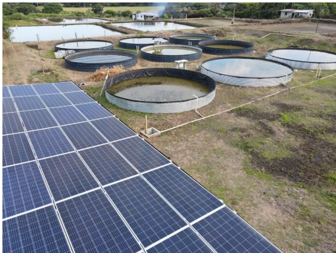
En la foto: Paneles solares usados para generar la energía fotovoltaica necesaria para el proceso cría y levante de los peces
