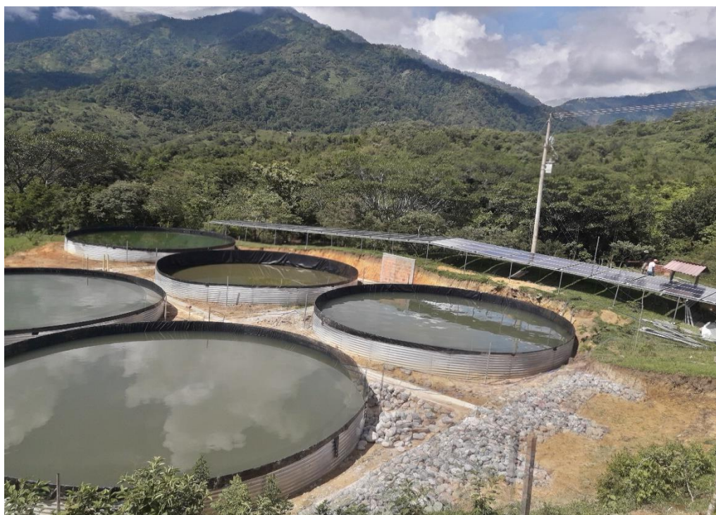
Tanques de almacenamiento y permanencia de la Biomasa
